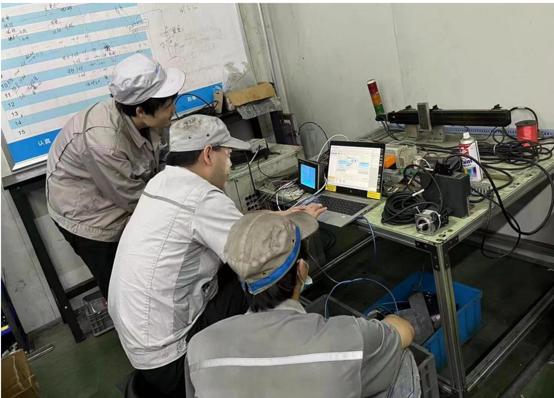
图 4-8 机电专业实习生现场调试 PLC 控制系统
