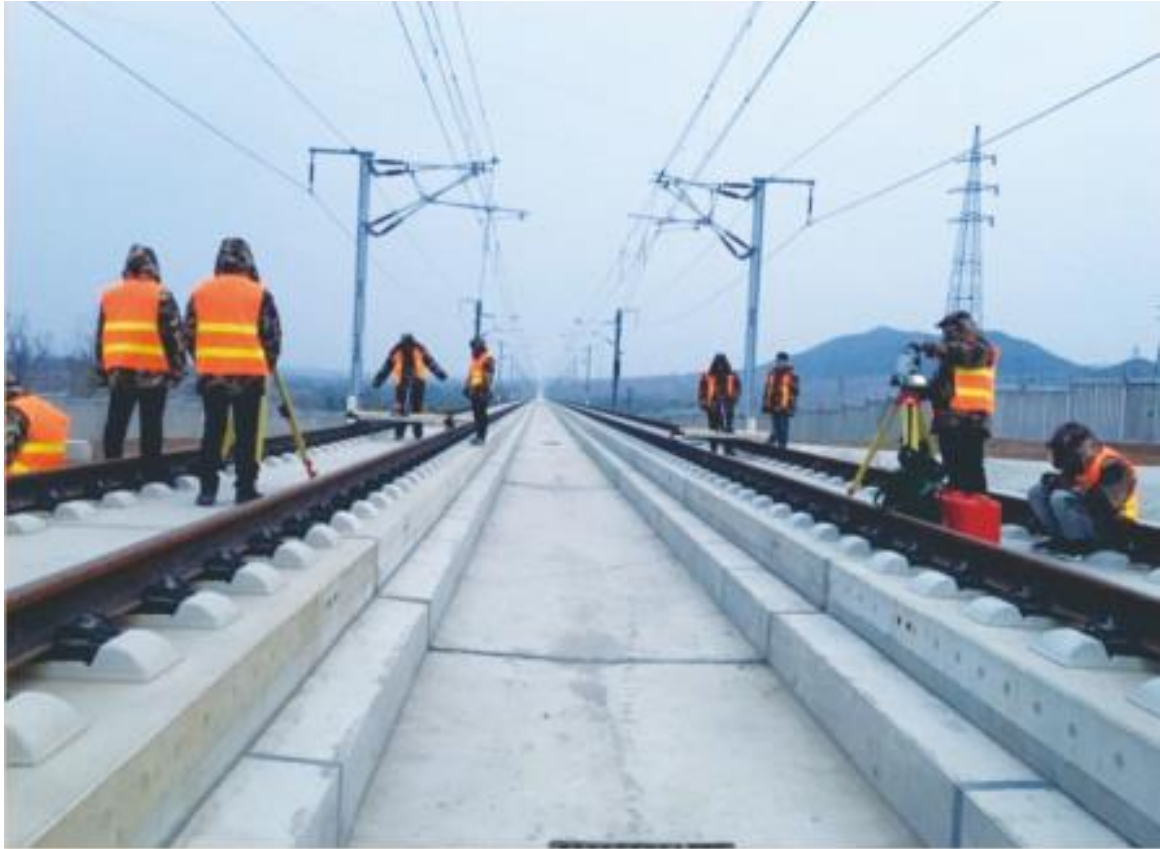
图 4-12 昌景黄高铁轨道精调测量项目现场
